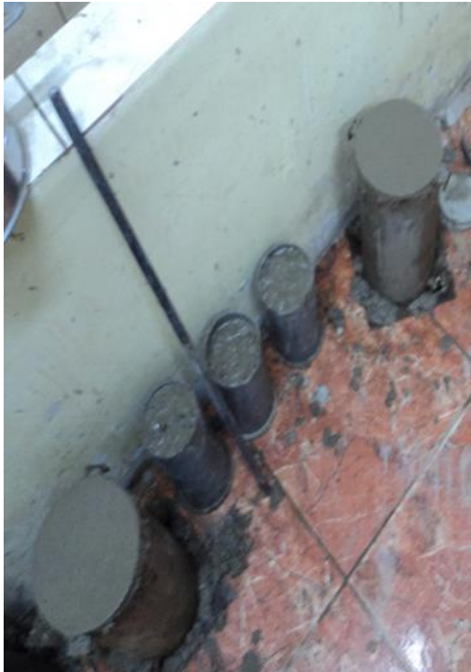
FOTO 07: Segunda capa de concreto vaciada sobre la primera tratada con adhesivo estructural SIKADUR GEL 32
