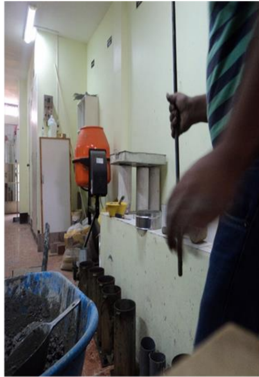
FOTO 02: Elaboración de probetas de concreto a medio llenar
