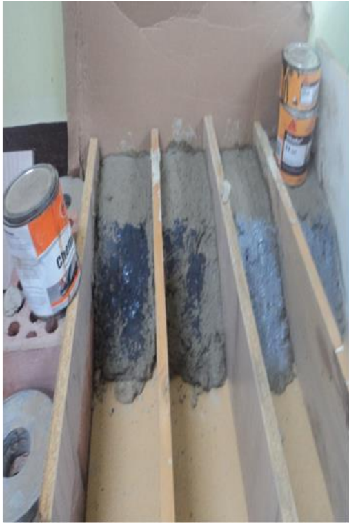
FOTO 17: Aplicación de adhesivos estructurales SIKADUR GEL 32 y CHEMA EPOXI ADHESIVO 32 en junta fría
