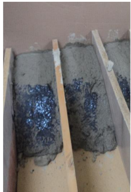
FOTO 16: Aplicación de adhesivos estructurales sobre superficie achaflanada de testigos prismáticos para siguiente vaciado.
