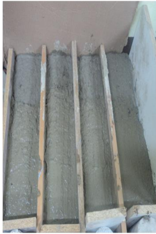
FOTO 18: Vaciado de 2ª parte de concreto en testigos tratados con adhesivo estructural en junta fría
