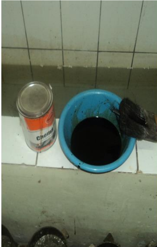
FOTO 09: Dosificación y preparación de adhesivo estructural CHEMA EPOX ADHESIVO 32
