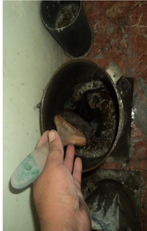
FOTO 10: Aplicación de adhesivo estructural SIKADUR GEL 32 sobre junta fría (primera porción de concreto).
