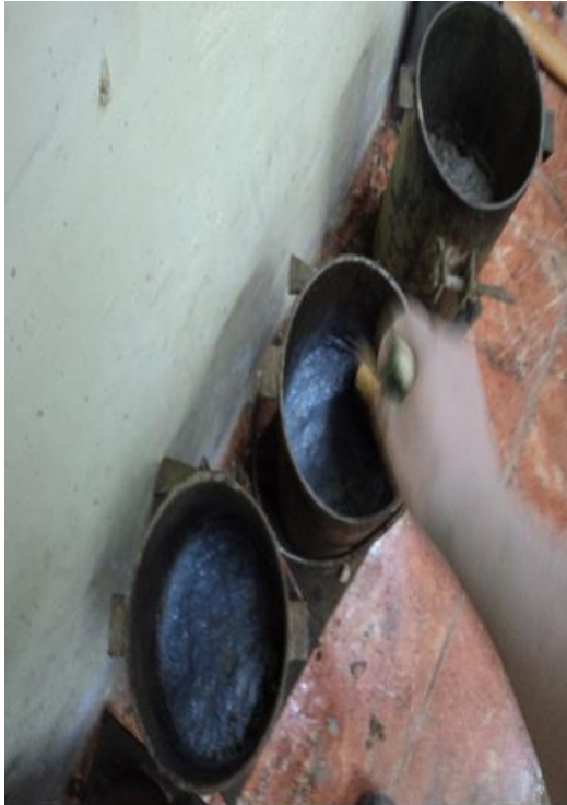
FOTO 05: Aplicación de adhesivo estructural SIKADUR GEL 32 sobre junta fría (primera porción de concreto).
