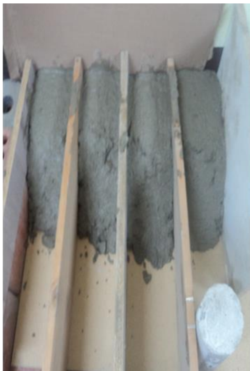
FOTO 15: Elaboración de testigos prismáticos de achaflanada para unión de concretos de distinta edad de vaciado
