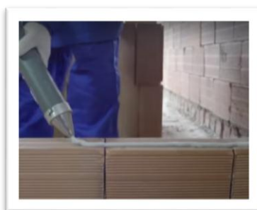
Figura N° 96 (21) APLICACIÓN DE MASA DUN DUN EN LADRILLO FUENTE: REVISTA OBRA
