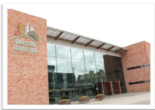
FIGURA Nº 2 FACHADA ACTUAL DE MERCADO FUENTE: CESAR MACHADO – WEB (4)
