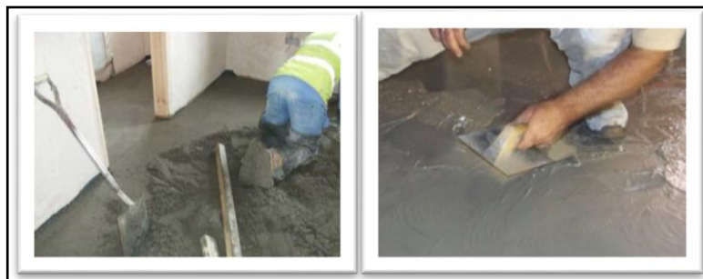
Figura N° 120 APLICACIÓN DE CEMENTO COMUN FUENTE: CEMENTO PACASMAYO
