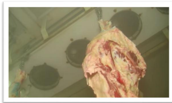
Figura N°52 (15) EQUIPAMIENTO EN ALMACEN DE REFRIGERACIÓN FUENTE: TV.GAN
