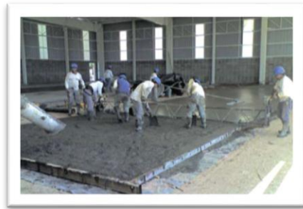
Figura N° 119 EJECUCIÓN DE TRABAJO DE CEMENTO PULIDO FUENTE: CEMENTO PACASMAYO
