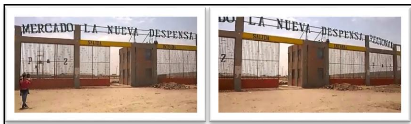
Figura N°174 FACHADA ACTUAL DEL MERCADO LA DESPENSA FUENTE: PROPIA
