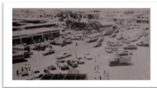
Figura N°159 VISTA DE CARGA Y DESCARGA (A LA IZQUIERA), HOY PLATAFORMA CUGLIEVAN FUENTE: WEB MERCADO MODELO
