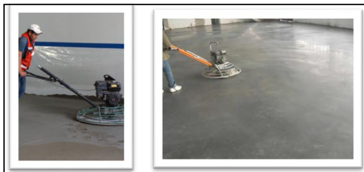
Figura N° 121 PULIDO DEL PISO FUENTE: CEMENTO PACASMAYO
