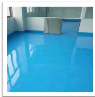
Figura N° 103 PISO EPÓXICO DE COLOR PARA OFICINA FUENTE: SODIMAC
