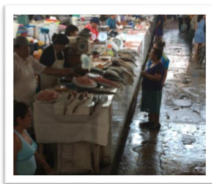
Figura N°162 CALALETAS DE DESAGUE EN MAL ESTADO FUENTE: PROPIA – ZONA HUMEDA-VENTA DE PESCADO
