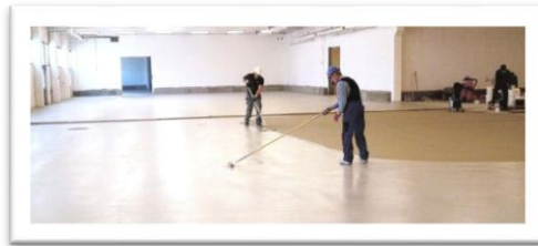
Figura N°102 REALIZACIÓN DE PISO EPOXICO SIKA PERÚ FUENTE: SODIMAC
