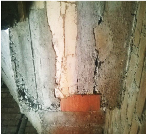
Acero de columna expuesto a la corrosión.
