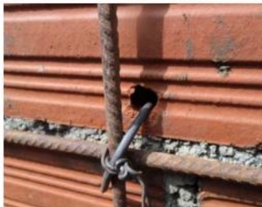
Figura 23. Detalle del anclaje.
