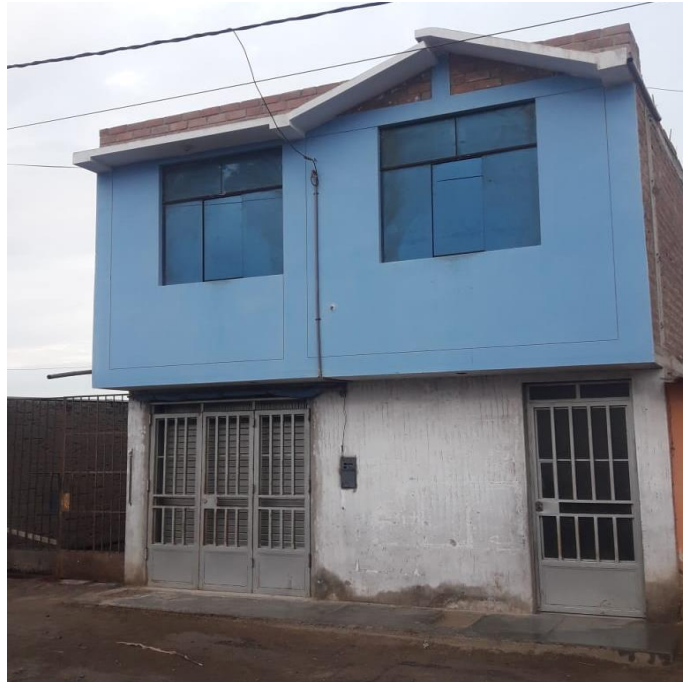
Foto de fachada.
