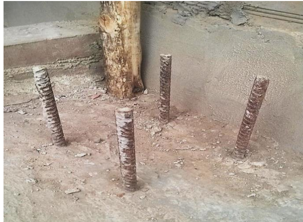
Acero de columna expuesto a la corrosión.
