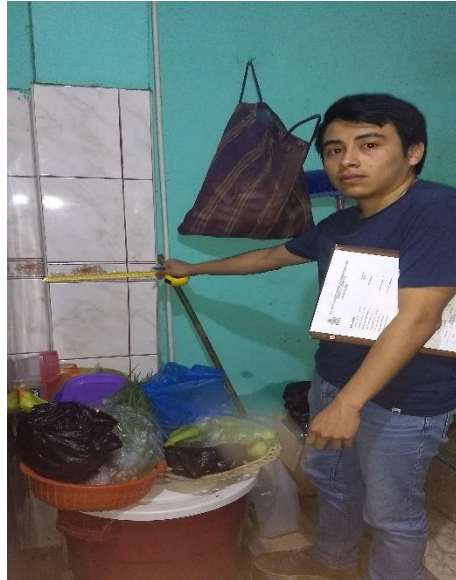
Medición de ancho de columnas.
