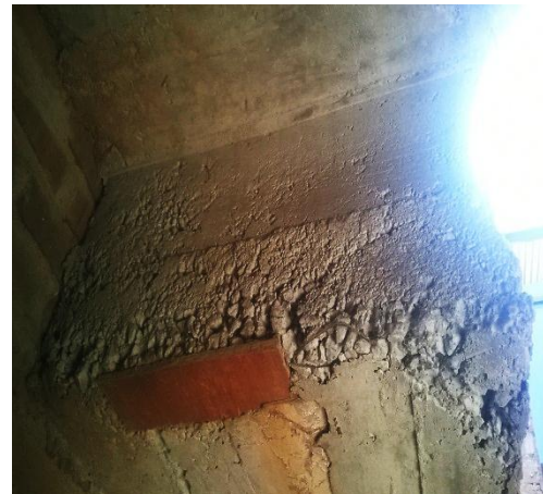
Acero de columna expuesto a la corrosión.
