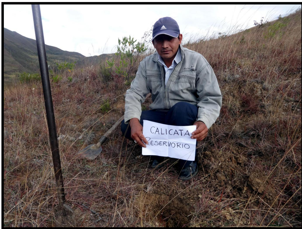
FOTO N°16: CALICATA EN RESERVORIO PROYECTADO.
