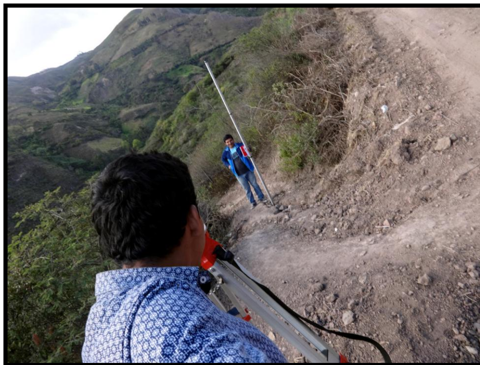
FOTO N°09: TOPOGRAFÍA DE LA LINEA DE CONDUCCIÓN.
