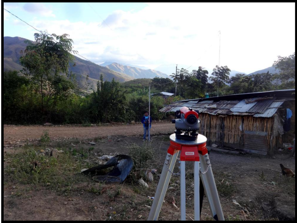
FOTO N°10: TOPOGRAFÍA DE LA LINEA DE DISTRIBUCIÓN.
