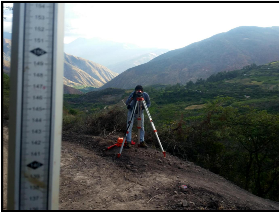
FOTO N°08: TOPOGRAFÍA DE LA LINEA DE CONDUCCIÓN.
