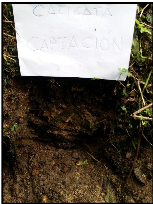
FOTO N°15: CALICATA EN CAPTACIÓN.
