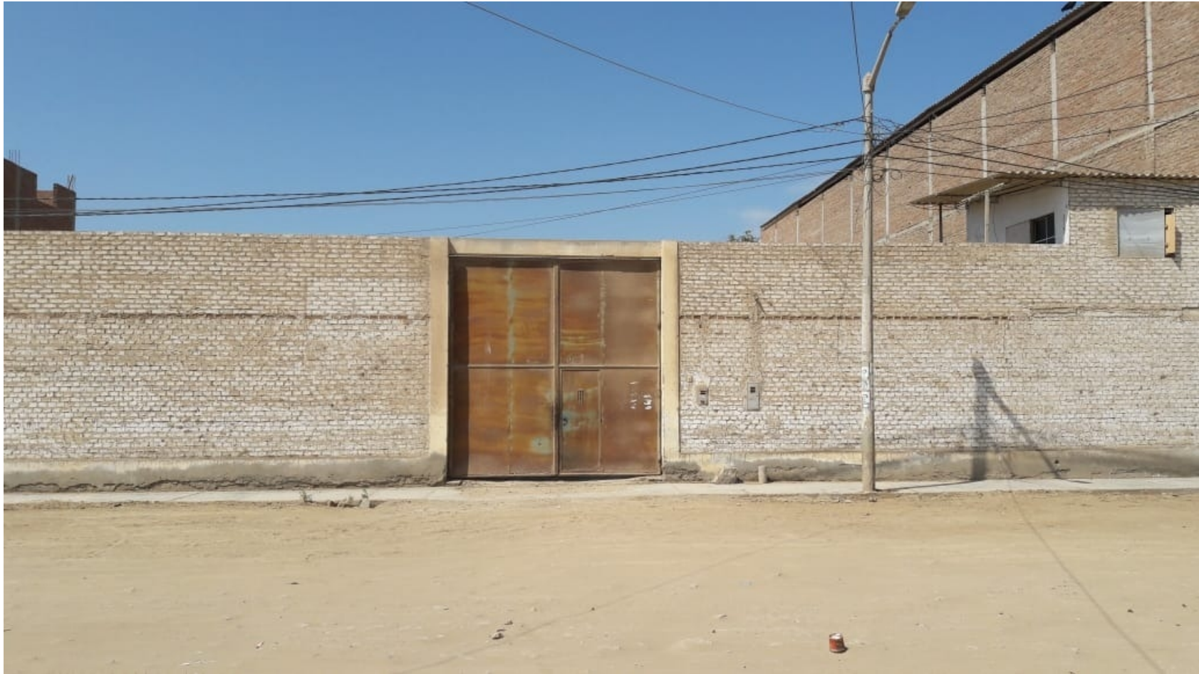
Anexo 1. Fachada del terreno en el que se proyectara el edificio para el proyecto de investigación
