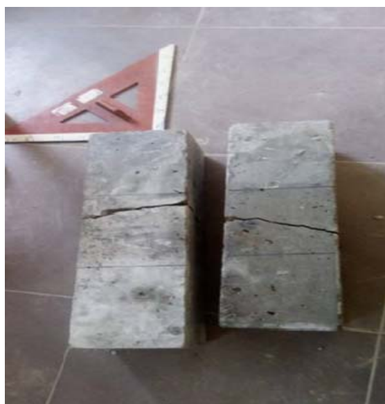
Foto 15. Resultado de rotura de testigos de concreto de forma de viga
