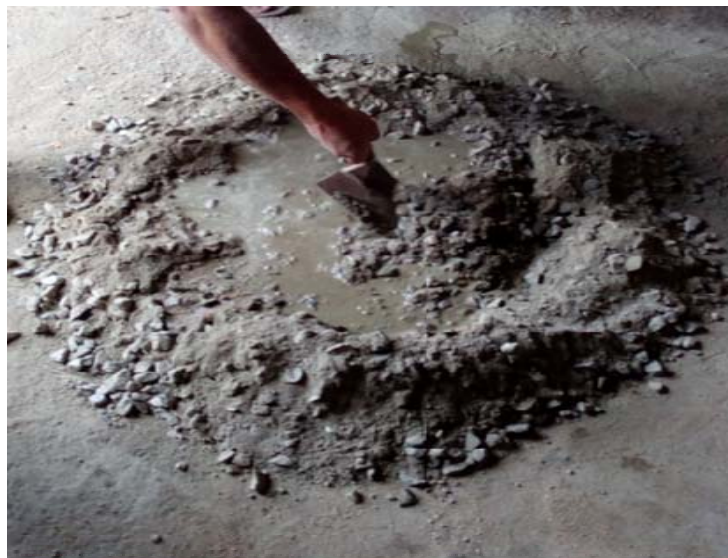
Foto 4. Elaboración de concreto convencional para determinación del diseño de mezcla
