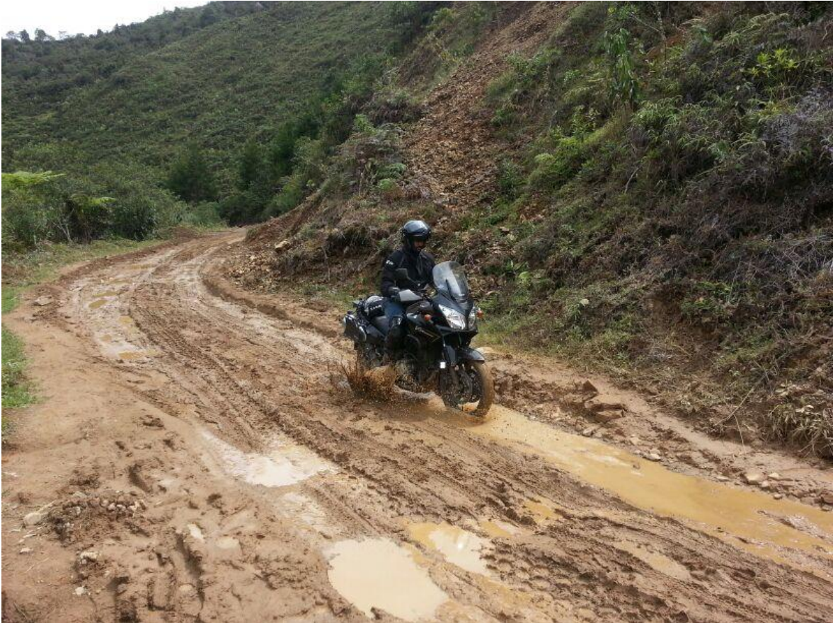
Figura 6. Gravedad 3: Profundidad \geq 10 cm
