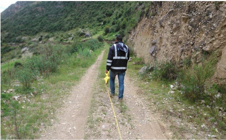
Figura 1. Gravedad 1: Huellas/hundimientos sensibles al usuario, pero < 5 cm
