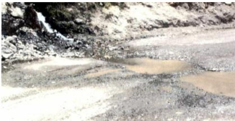
Figura 12. Cruce de agua
