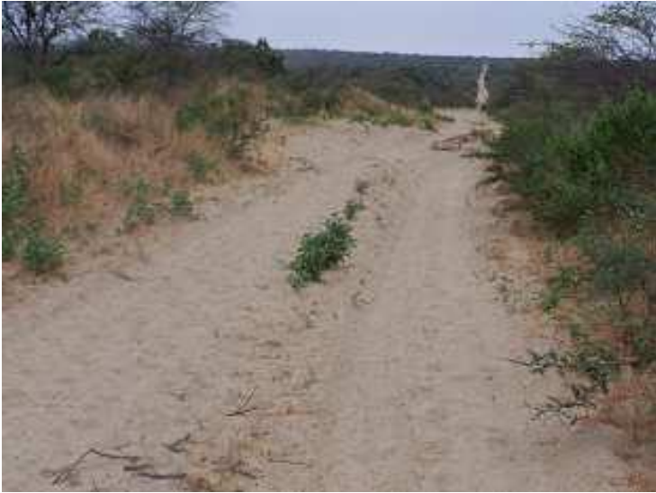
Figura 4. Gravedad 1: Sensible al usuario pero profundidad < 5 cm
