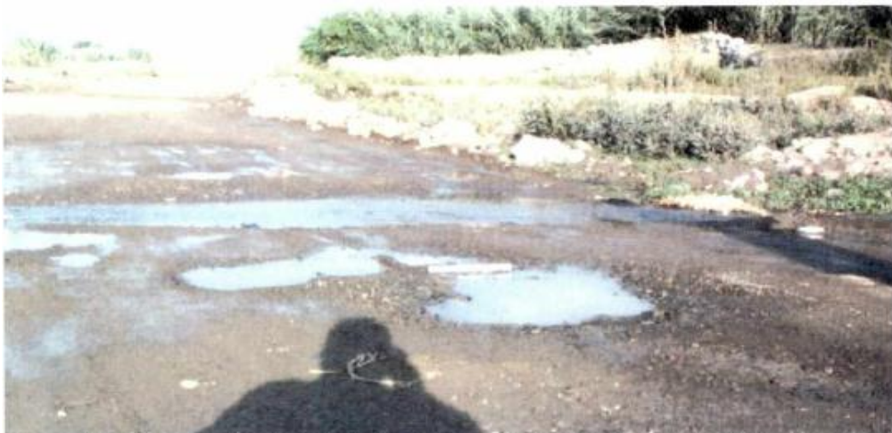
Figura 9. Gravedad 3: Necesita una reconstrucción
