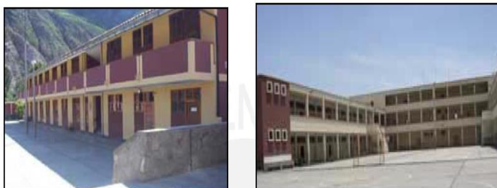
Figura 1: Edificio Educativo moderno (izq) y Gran Unidad Escolar antiguo (der)
