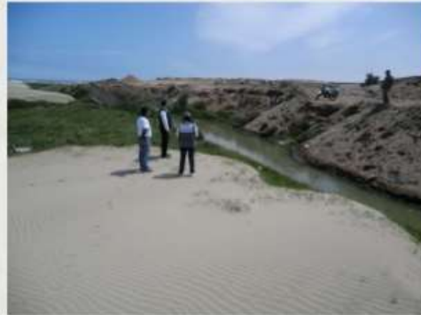
Dren 3000 cerca a la desembocadura en el mar
