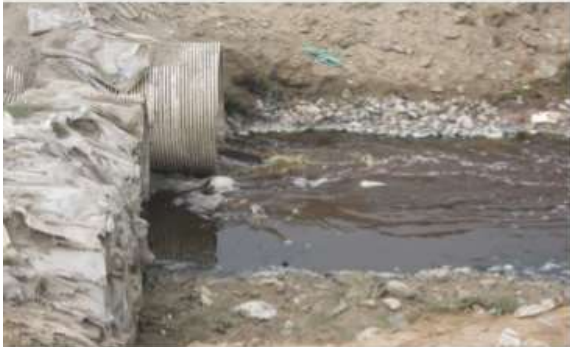
Dren 4000 con cruce carretera Santa Rosa
