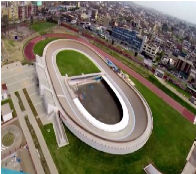
Figura 5. Velódromo, V.N. Videna, 2015. Se muestra la construcción casi completa.
