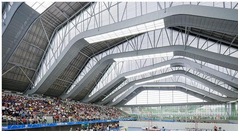
IMAGEN INTERIOR DEL TIPO DE COBERTURA
