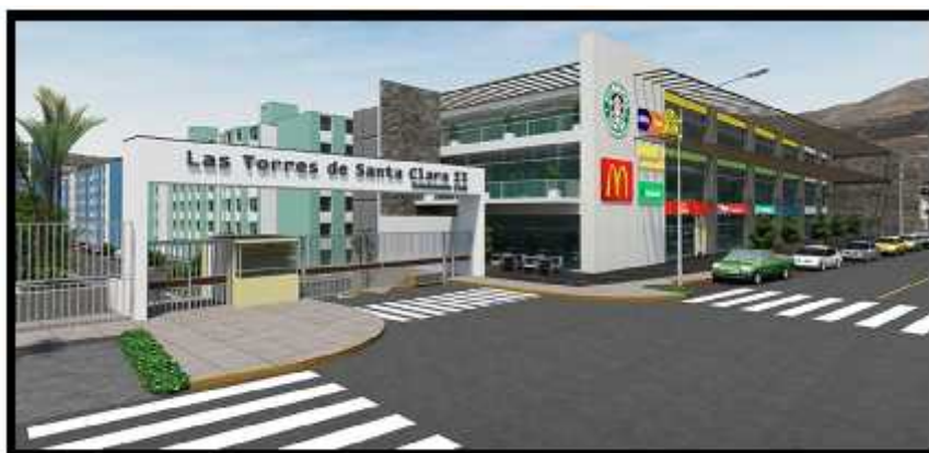
Figura N°27 Vista 1 del ingreso principal, de las TORRES DE SANTA CLARA II.
