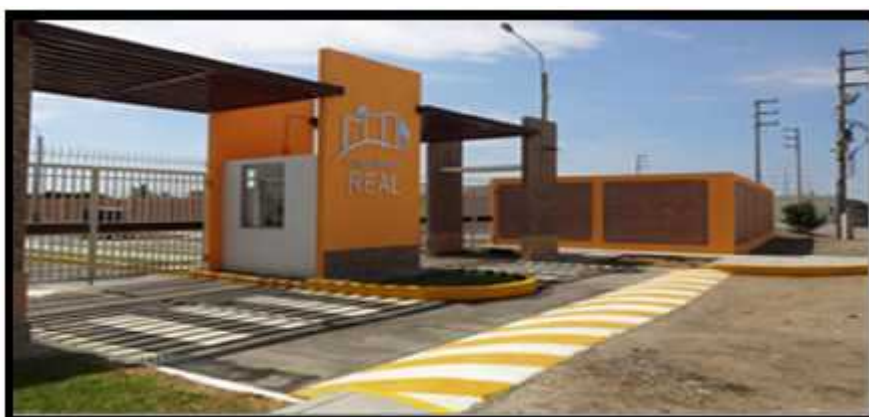
Figura N°32 Vista 1, del Pórtico de Ingreso del Condominio REAL
