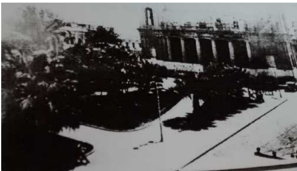
Figura N°4 Construcción de la Catedral, frente al Parque Principal, lleno de Palmeras.
