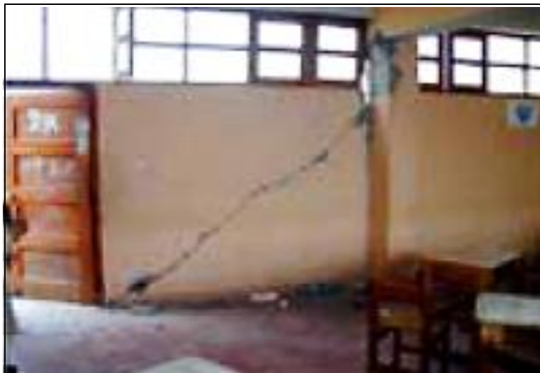
Figura N° 19: Efecto Columna Corta Fuente: Natividad Arevalo, 2006
