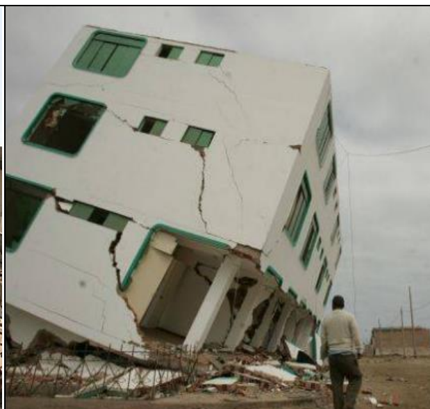
Figura N° 2: Vivienda de material noble ante un sismo-pisco2007. Fuente: Elcomercio.pe
