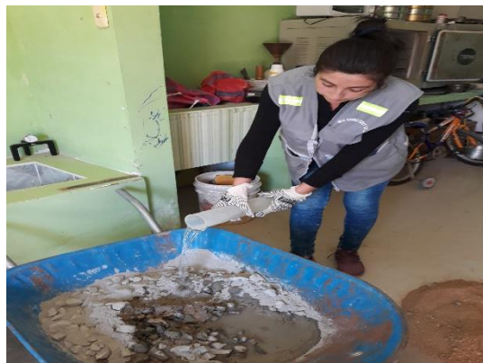
Figura 40: se procede a mezclar los agregados para obtener concreto fresco
