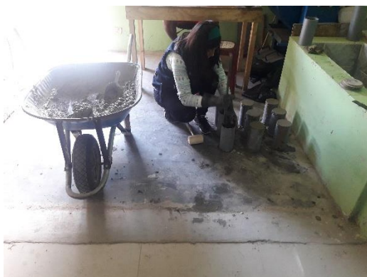
Figura 50: llenado de concreto
