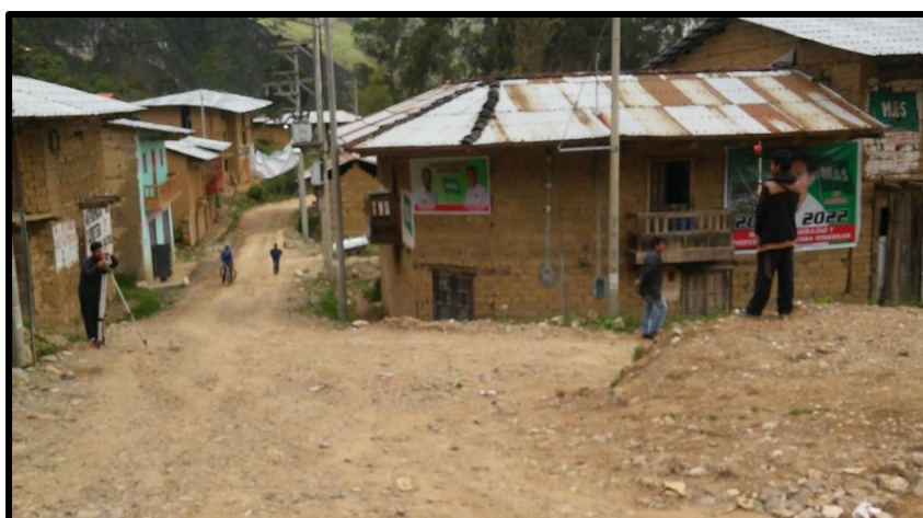
Figura 1. Condición de Calle 01.
