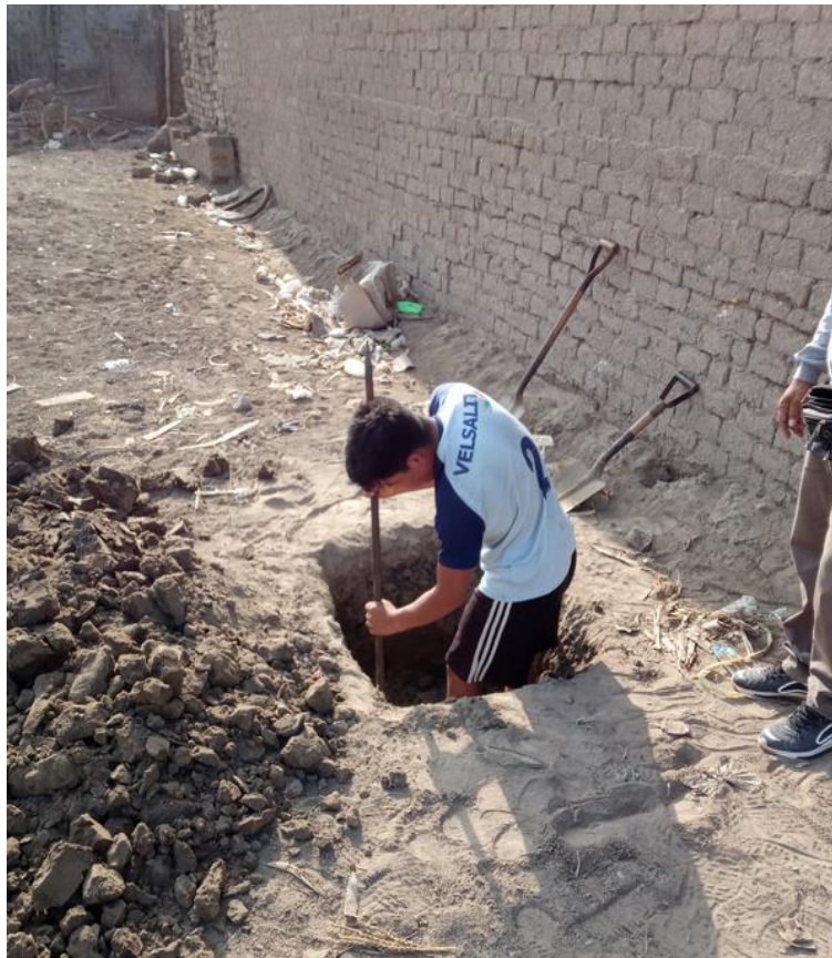
Fotografía 13: Calicata en la zona de estudio. Fuente: Propia, 2021.
