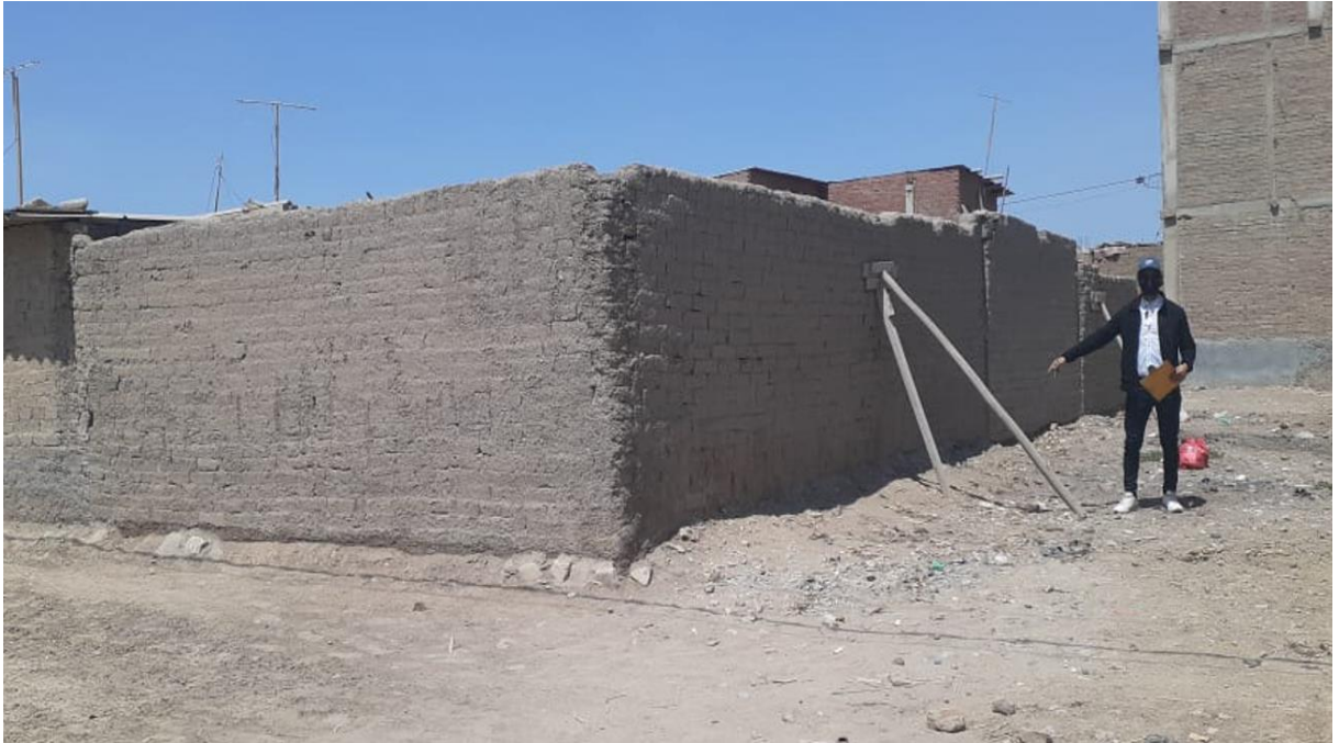
Fotografía 9: Inspección de las viviendas de adobe. Fuente: Propia, 2021.
