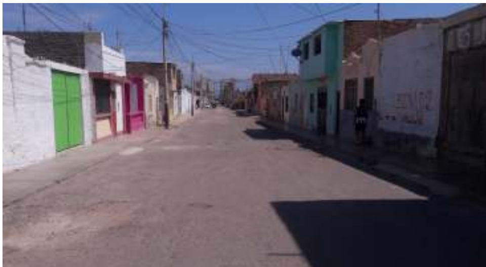
Figura N° 1: Deterioro de la Av. Torres Paz.
