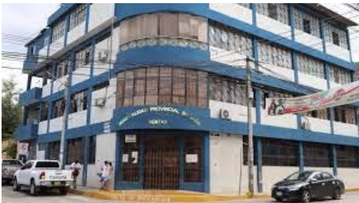
Edificio de la Oficina de Rentas de La Municipalidad Provincial de Jaén.
