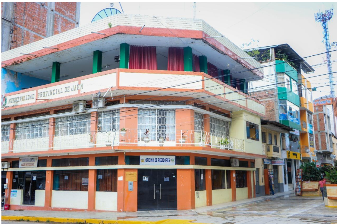
Edificio de la Sede Alcaldía de La Municipalidad Provincial de Jaén.
