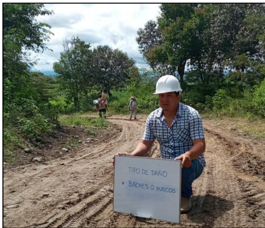
Figura 37. Deterioro o falla lodazal.
