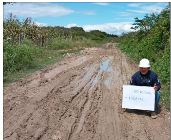
Figura 12. deterioro lodazal.
