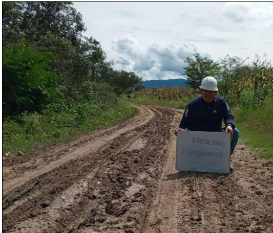
Figura 9. Deterioro deformación.
