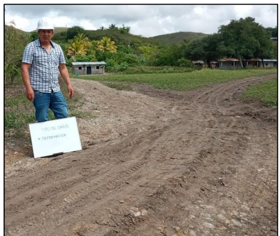
Figura 40. Deterioro o falla deformación.
