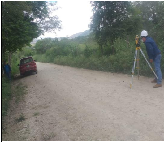
Figura 23. Estación 6 visando cerco
