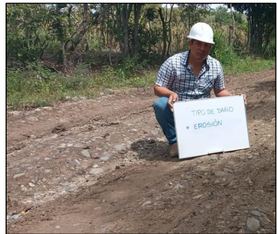
Figura 38. Deterioro o falla erosión.
