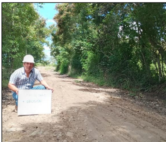
Figura 39. Deterioro o falla erosión.
