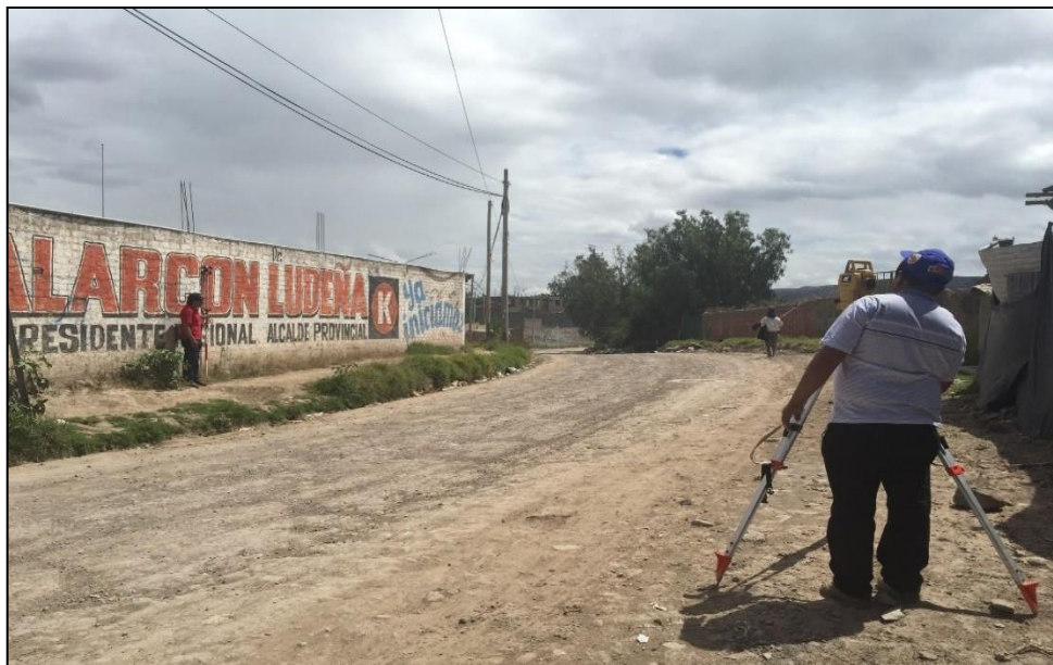
Figura 4. Uso de la estación total.
