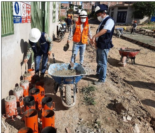
Figura 11. Varillado de concreto en el molde
