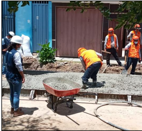
Figura 45. Enrasado de testigos
