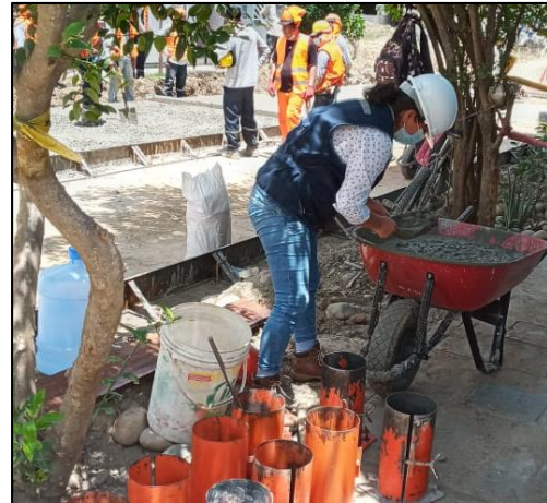
Figura 46. Curado de testigos de concreto
