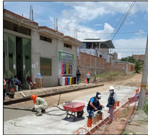
Figura 52. Curado en obra
