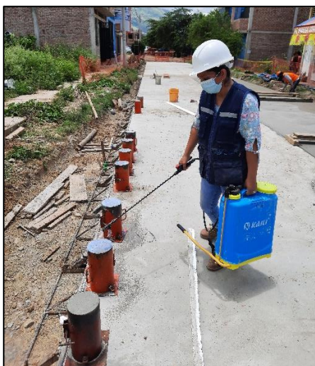
Figura 65. Curado en obra
