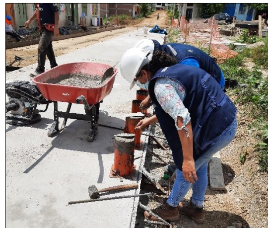
Figura 12. Enrasado de concreto en el molde
