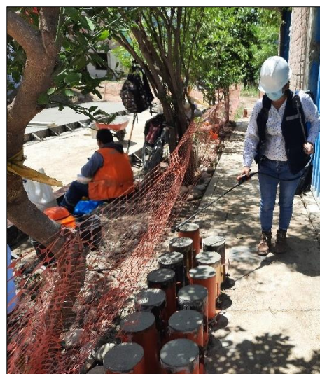
Figura 14. Curado de testigos de concreto en obra
