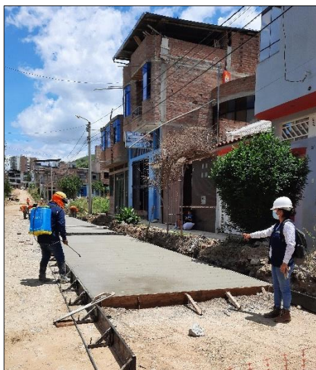
Figura 13. Curado del concreto del pavimento en obra
