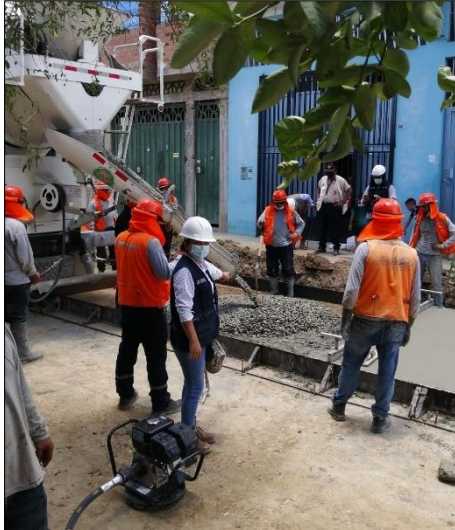
Figura 3. Proceso de vaciado del concreto desde el mixer
