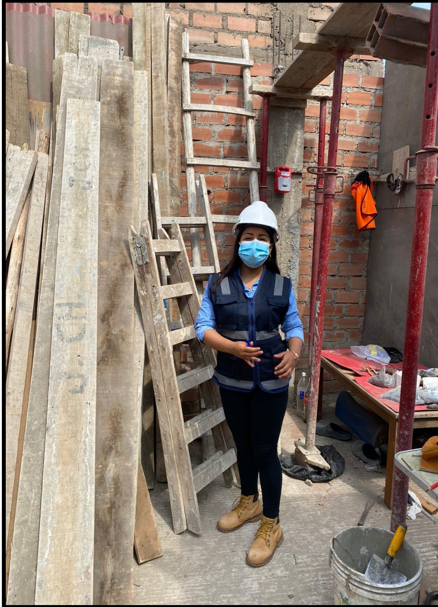
Ilustración 7: Identificación de edificación en construcción
