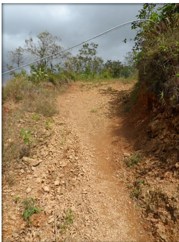
FOTO N° 06 PASE AEREO EXPUESTO
