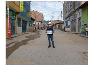
UN. DE MUESTRA : 04 - PROGRESIVA 00+146.20 AL 00+195.50 KM
