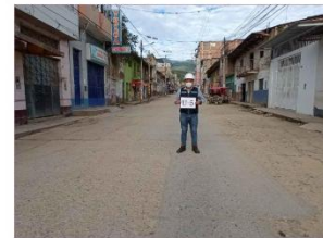
UN. DE MUESTRA : 05 - PROGRESIVA 00+195.50 AL 00+249.30 KM
