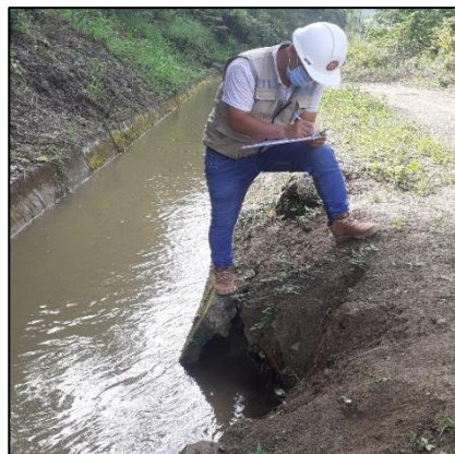
Figura 27. Identificación de patología de fisuras y vegetación.
