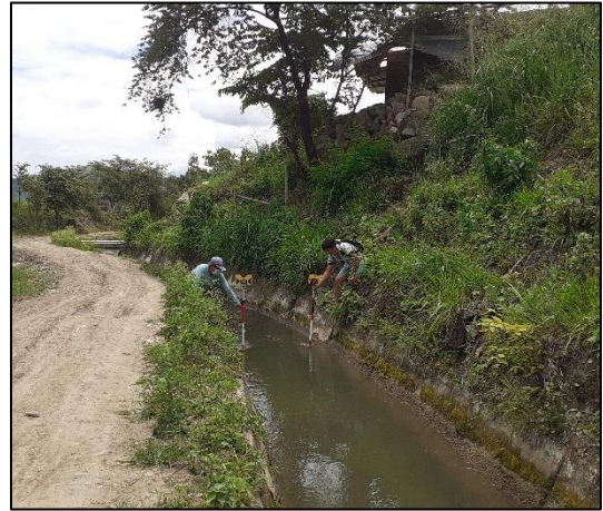
Figura 13. Vista fondo del canal.
