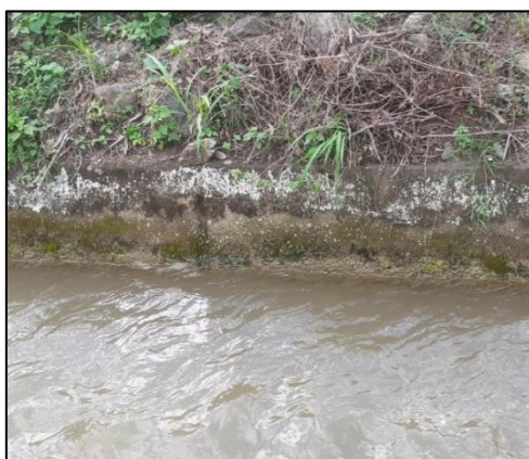
Figura 28. Identificación de patología de erosión y vegetación.
