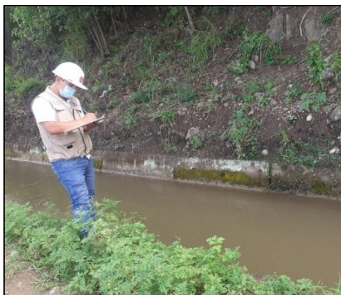
Figura 28. Identificación de patología de erosión y vegetación.
