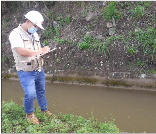
Figura 5. Identificación de patologías (vegetación)
