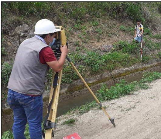
Figura 16. Vista borde del canal.
