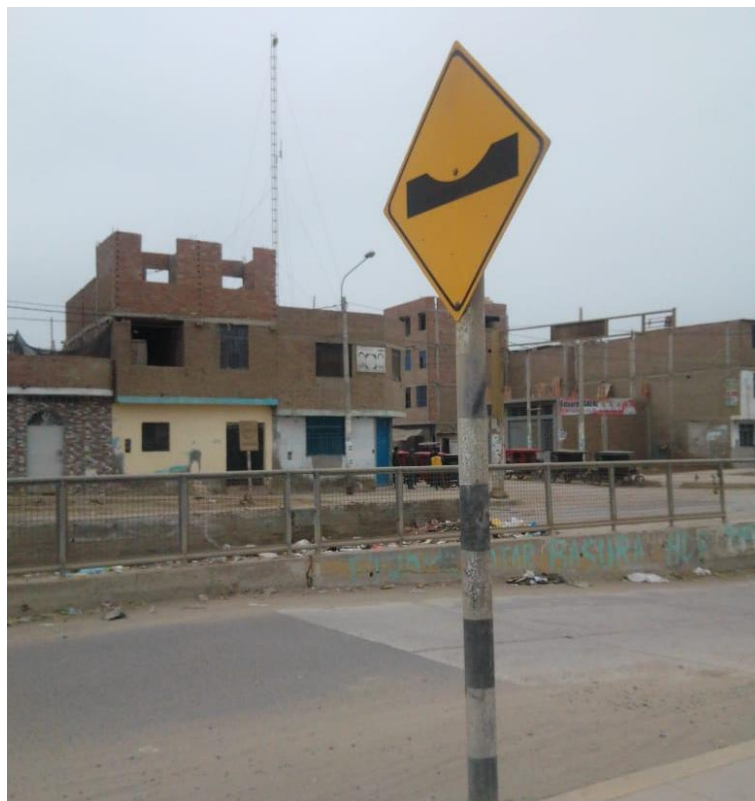
Fotografía N° 5: Mal estado de las señales reglamentarias
