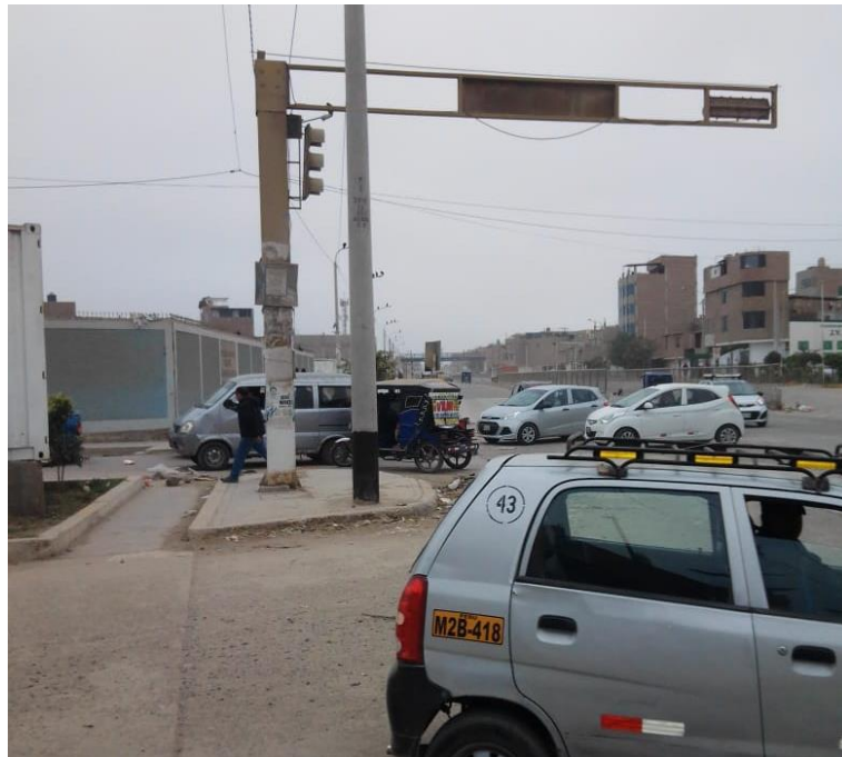
Fotografía N° 4. Semáforos que no están funcionando.
