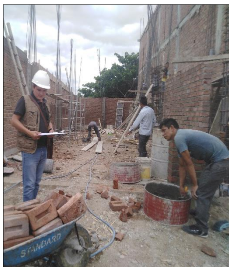
Figura 3. Identificación de cuadrillas que trabajaron en el asentado de ladrillo en la obra 01.
