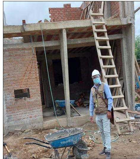
Figura 6. Muestreo de mortero en obra 04.
