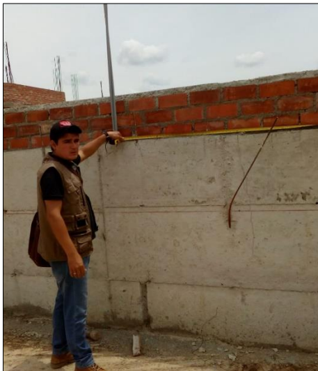
Figura 41. Medición de longitud de muro asentado con aparejo de soga.
