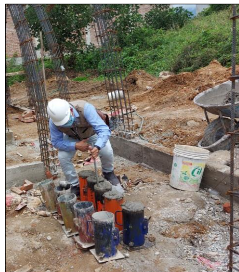
Figura 8. Elaboración de testigos de mortero en obra 03.
