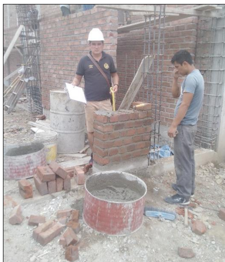
Figura 1. Medición de muro asentado de cabeza en obra 01.
