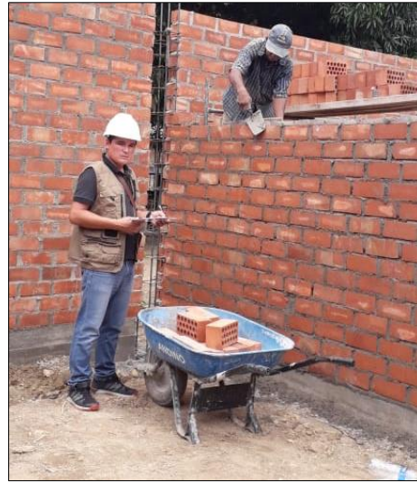
Figura 40. Asentado de ladrillo con aparejo de cabeza.
