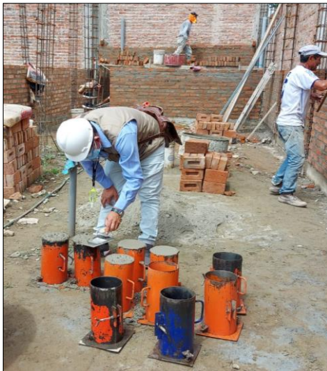
Figura 45. Elaboración de testigos de mortero.
