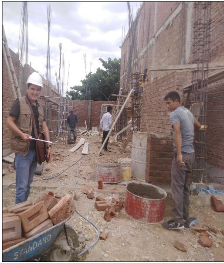
Figura 39. Asentado de ladrillo con aparejo de cabeza.
