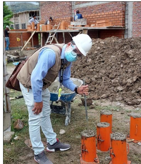
Figura 46. Proceso de vibración de concreto con varilla.
