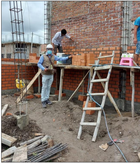
Figura 43. Observación de asentado de ladrillo con aparejo de sogá.
