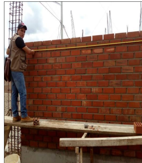
Figura 42. Medición de longitud de muro asentado con aparejo de soga.
