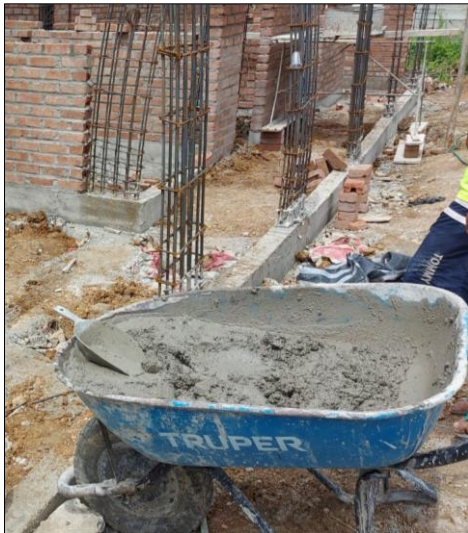
Figura 5. Muestreo de mortero en obra 03.
