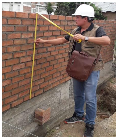
Figura 2. Medición de muro asentado de sogá en obra 04.
