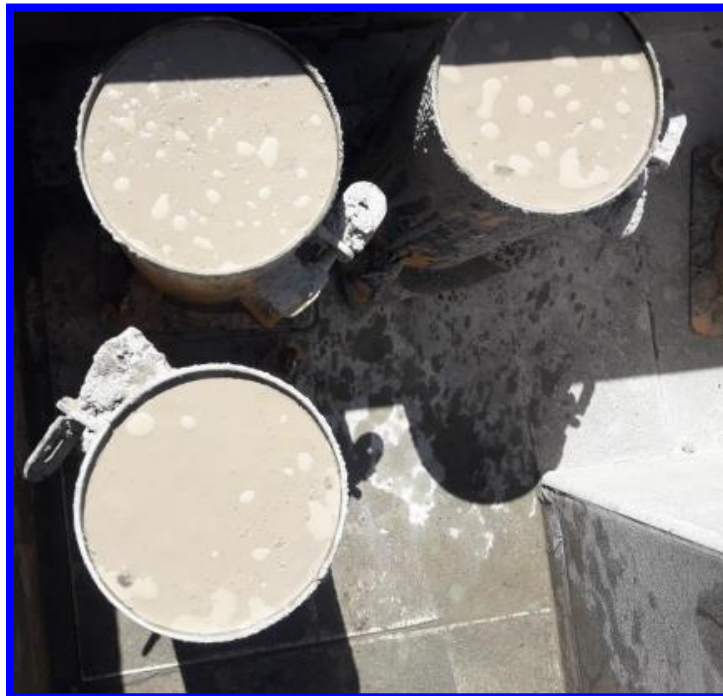
FOTOGRAFIA 10 - PROBETAS DE CONCRETO FAST TRACK EN PROCESO DE FRAGUADO
