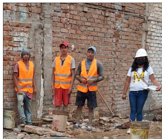
Figura 12. Difusión de especificaciones técnicas mínimas para lograr un concreto de calidad.
