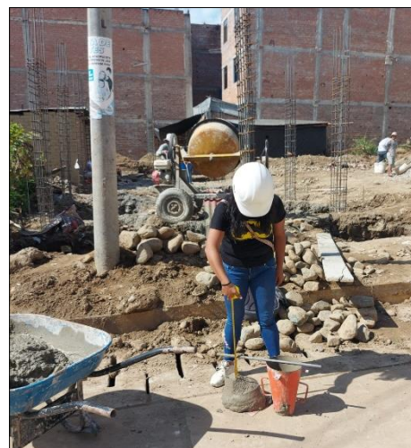
Figura 4. Medición del asentamiento (Slump) del concreto
