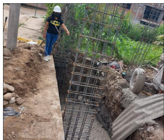
Figura 39. Concreto colocado en cimentaciones
