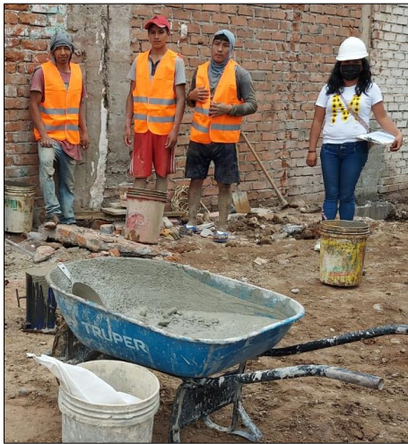
Figura 1. Muestreo de concreto
