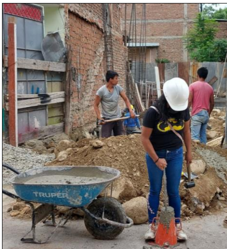
Figura 3. Proceso de varillado del concreto en el cono de Abrams
