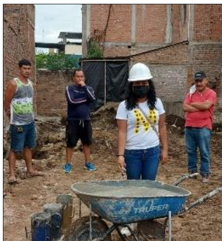
Figura 5. Realización del ensayo para medir la temperatura del concreto
