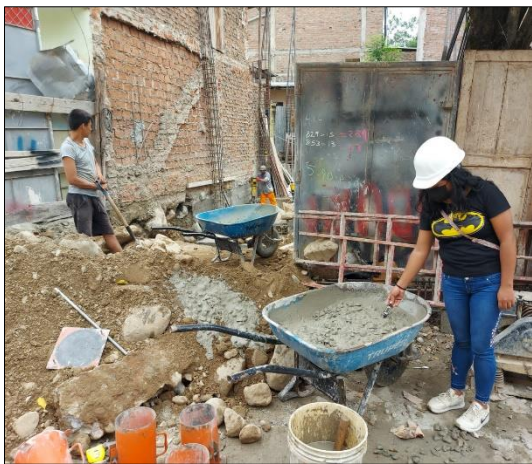
Figura 38. Proceso de elaboración de concreto
