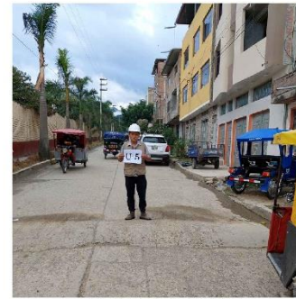
UM-05 - PAÑOS DEL 65 AL 80 PROGRASIVA 00+150.12 km
