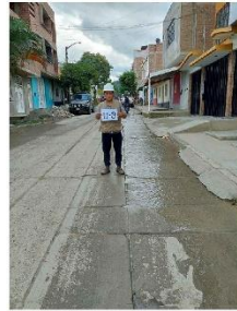
UM-03 - PAÑOS DEL 33 AL 48 PROGRASIVA 00+79.42 km
