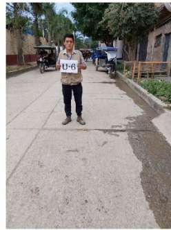
UM-06 - PAÑOS DEL 81 AL 96 PROGRASIVA 00+190.26 km
