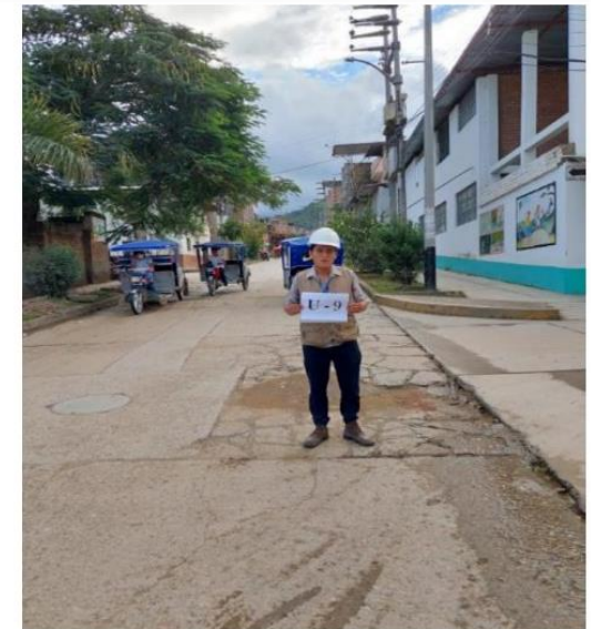
Vista de la Unidad de Muestra U-09 - Progresiva Inicial 00+305.67 km
