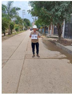
UM-08 - PAÑOS DEL 113 AL 128 PROGRASIVA 00+265.67 km
