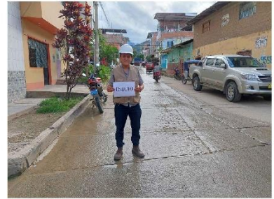
PROGRESIVA 00+00 km - INICIO CA. IQUITOS
