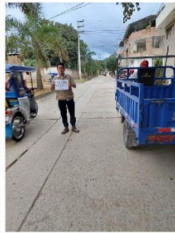
PAÑO 94 - PARCHE GRANDE SEVERIDAD LEVE
