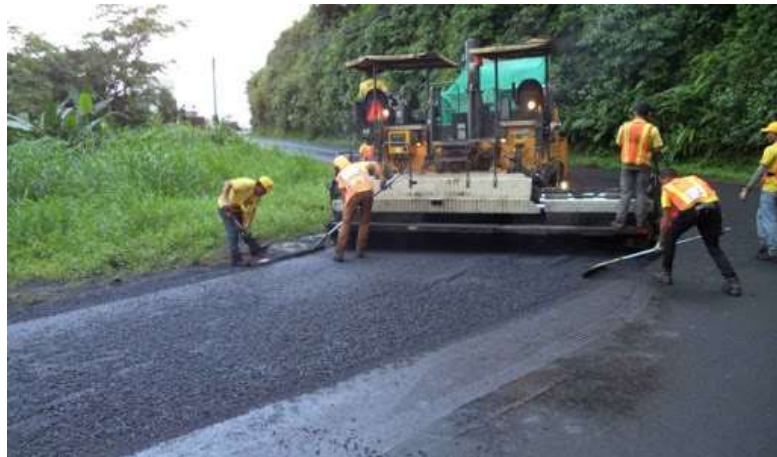
Figura 5:Inspección de conservación vial de la red vial nacional pavimentada
