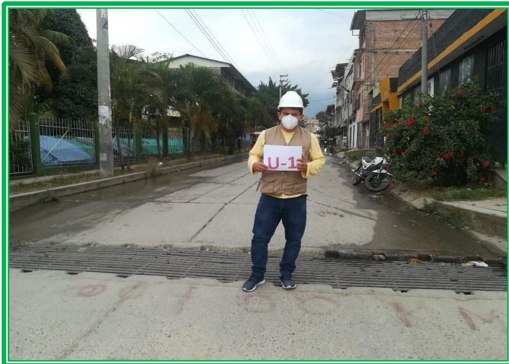
Foto 01. Vista Panorámica de la U-01 en la Progresiva 00+000km, Ubicado en la Calle Iquitos Cuadra N° 08 con Intersección Av. Pakamuros.
