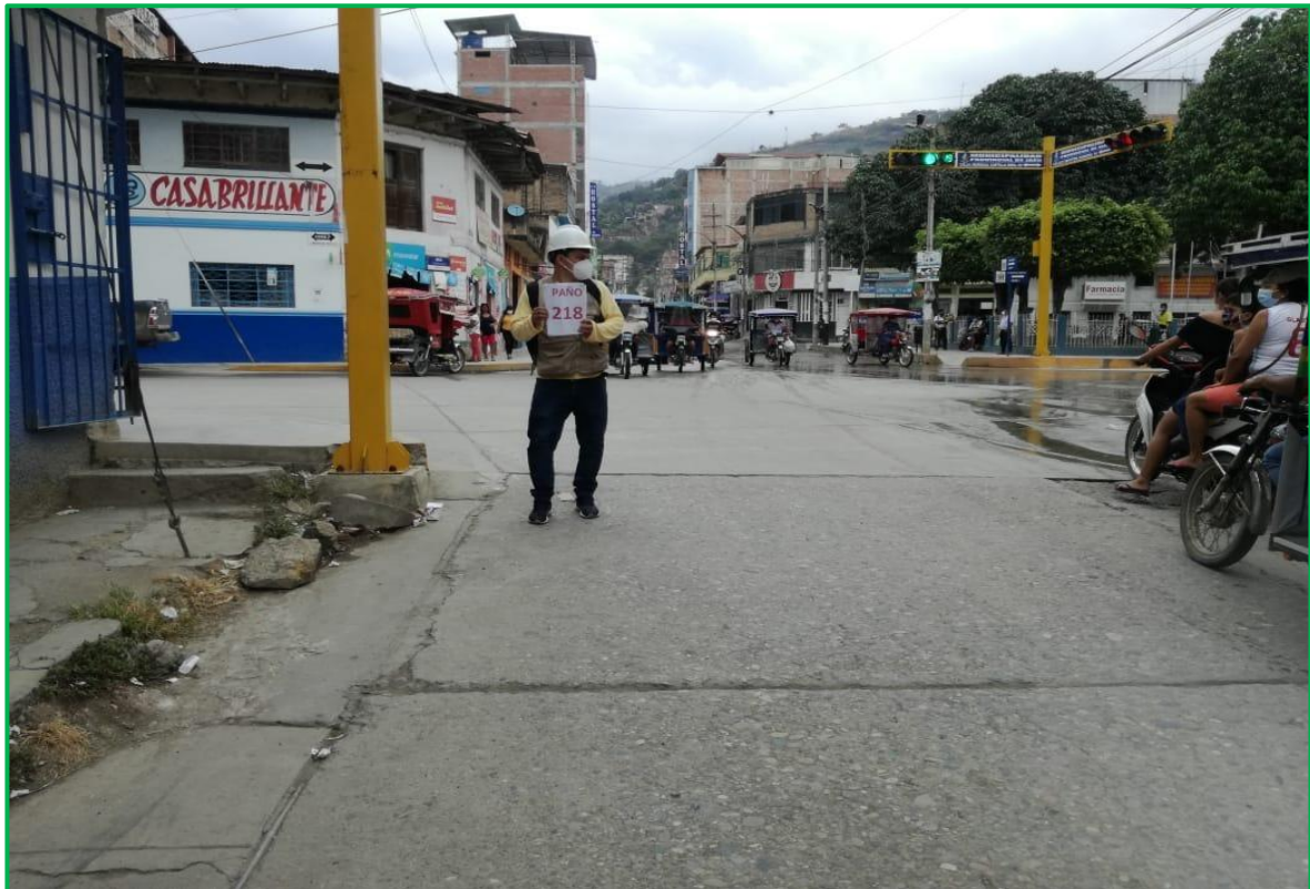
Fig. 7 Final Calle Iquitos Cuadra N° 14 Progresiva 0+579.7 Km
