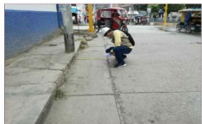
PAÑO 215 - ANCHO DE BERMA 0.60 m.
