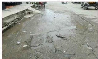
PAÑO 211 - FALLA DESCONCHAMIENTO, MAPA DE GRIETAS, CRAQUELADO DE SEVERIDAD ALTA
