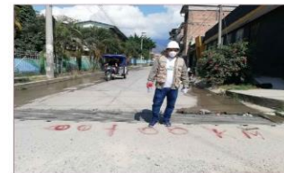
PROGRESIVA 00+00 km - INICIO CA. IQUITOS
