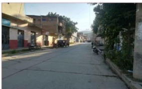
PASO 119 - PARCHEO Y JARDINES SIN MANTENIMIENTO
