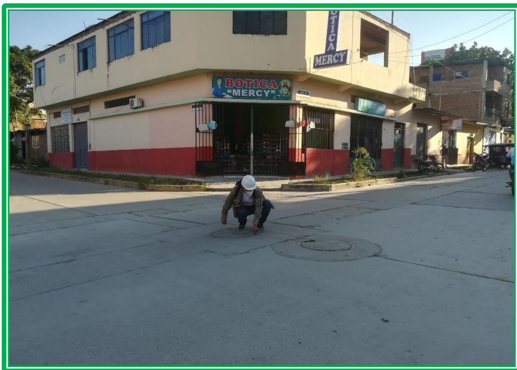
Foto 24. Paño 134, en la U-07, en la Intersección de la Calle Iquitos y Cajamarca, con medición y fallas 01 Parche Grande (29) de severidad Medio.
