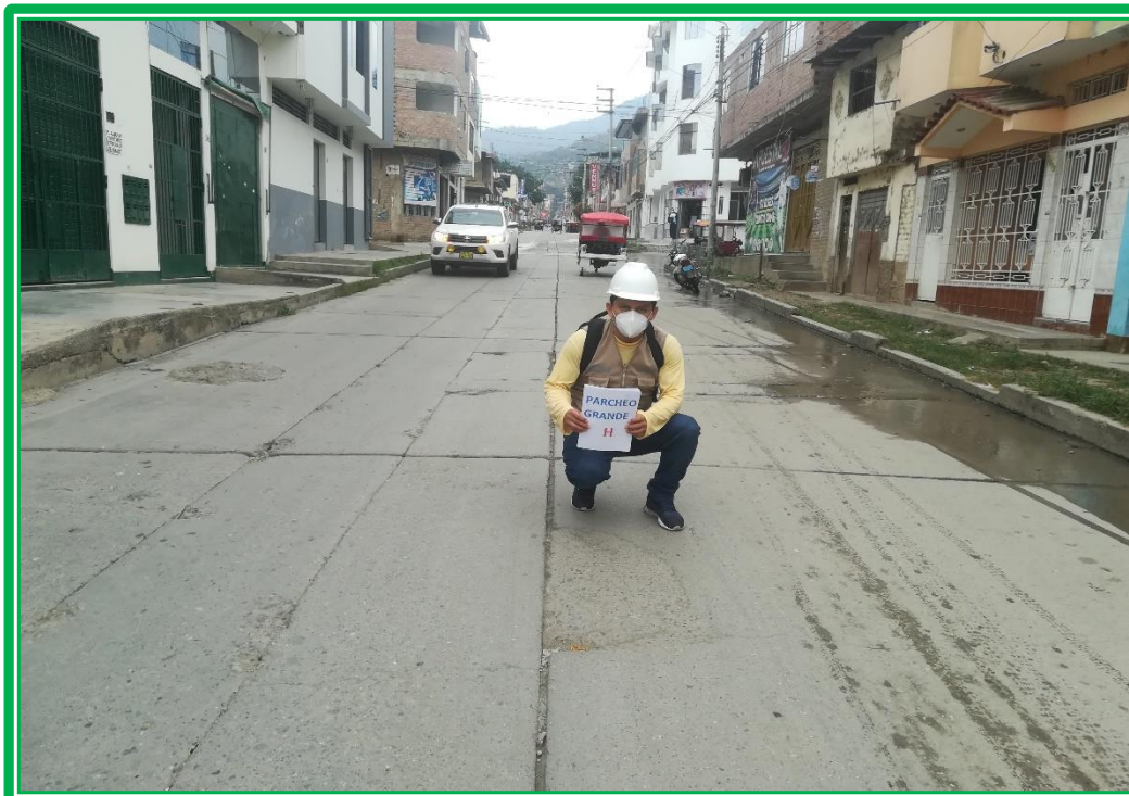
Foto 15. Paño 82, en la U-05, en Progresiva 0+198.0 Km, en la Cuadra N° 10, con fallas de 01 Escala (23) de severidad Alto ; y la Tapa de Buzón en mal estado.
