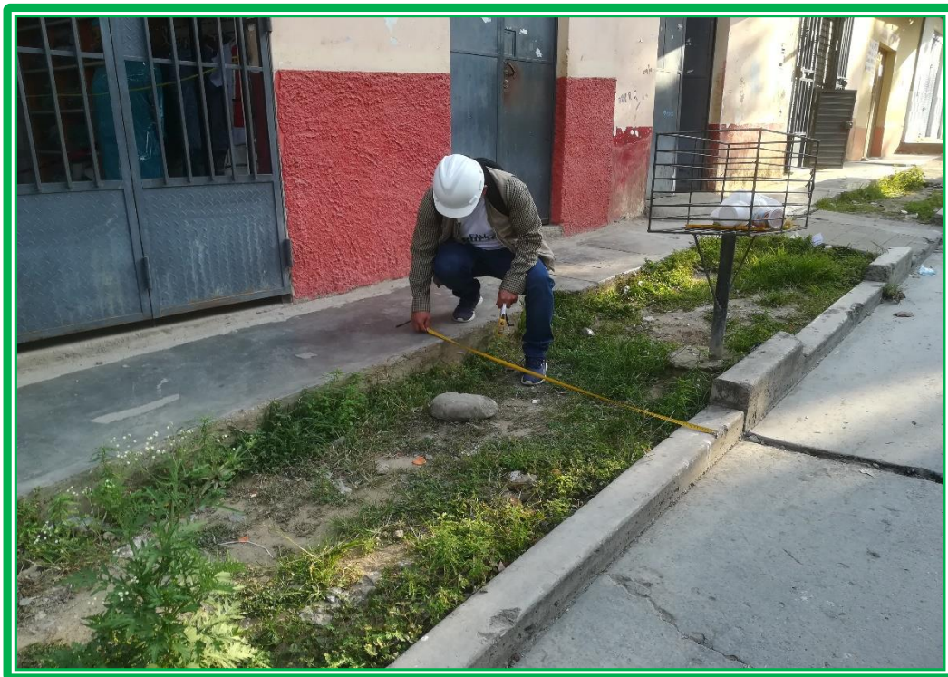
Foto 29. En la U-08, en la Cuadra N° 12, medición de Jardines de 1.50 m; sardineles de 0.15 m y vereda de 1.00 m.
