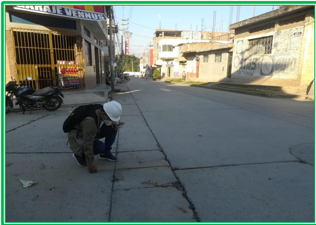
Foto 25. Paño 135, en la U-07, en la Intersección de la Calle Iquitos y Cajamarca, con medición de la berma de 0.80 en Estado Regular.
