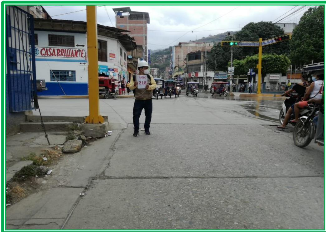
Foto 40. Paño 218, en la U-11, en la Cuadra N° 14, en la Progresiva Final 0+579.7 Km, con un Total de 218 Paños que Conforman las Cuadras N° 08 al 14 de la Calle Iquitos.
