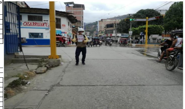
Vista de la Unidad de Muestra U-11 - Progresiva Final 00+ 579.70 km
