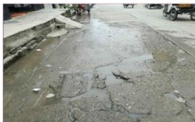
PAÑO 211 - FALLA DESCONCHAMIENTO, MAPA DE GRIETAS , CRAQUELADO DE SEVERIDAD ALTA
