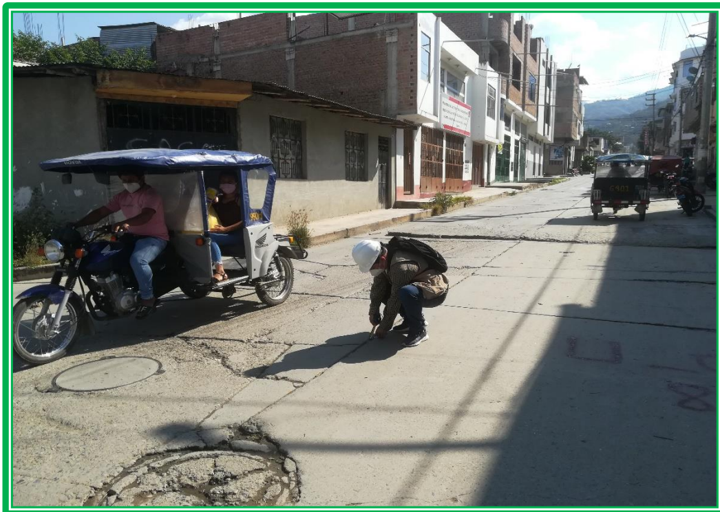
Foto 15. Paño 82, en la U-05, en Progresiva 0+198.0 Km, en la Cuadra N° 10, con fallas de 01 Escala (23) de severidad Alto ; y la Tapa de Buzón en mal estado.
