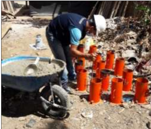
Figura 13. Elaboración de testigos de concreto en obra N° 03
