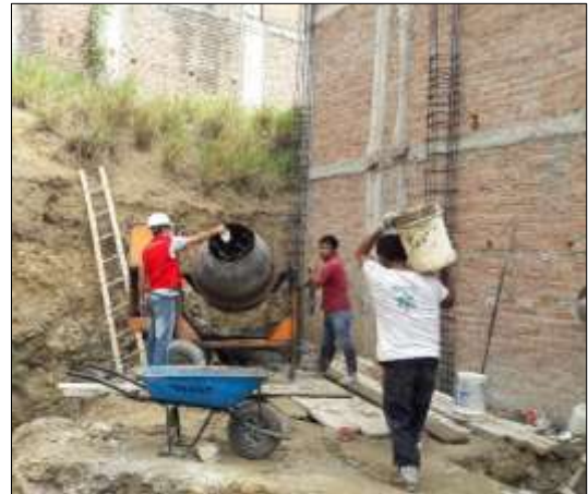
Figura 6. Colocación de aditivo en obra N° 02
