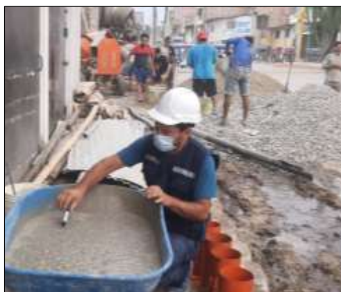
Figura 100. Elaboración de testigos de concreto
