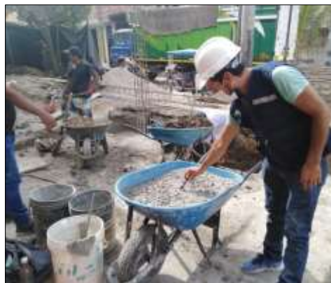
Figura 111. Elaboración de testigos de concreto
