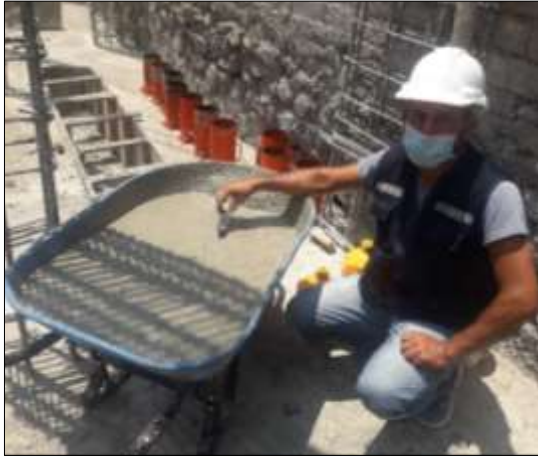
Figura 9. Realización de ensayo para medir la temperatura en obra N° 05
