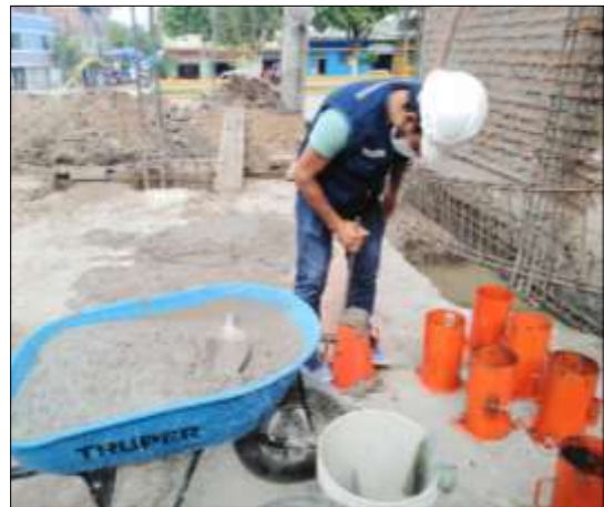
Figura 12. Realización de ensayo para medir el asentamiento (slump) en obra N° 08
