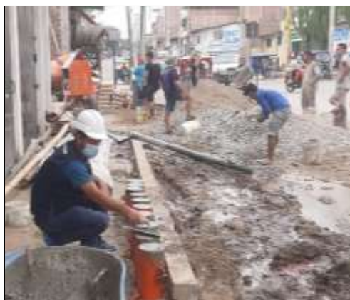
Figura 100. Elaboración de testigos de concreto
