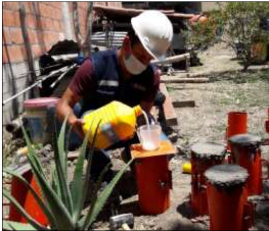
Figura 5. Medición del aditivo en obra N° 01
