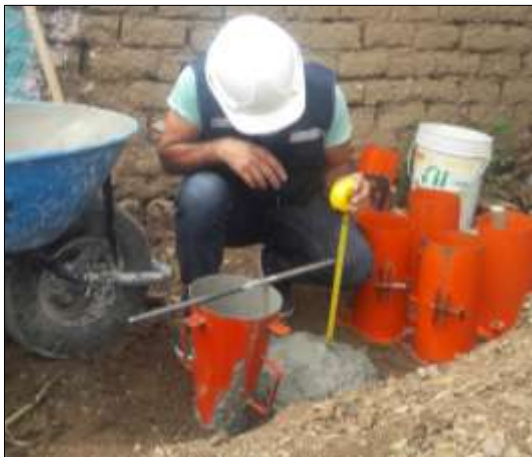
Figura 11. Realización de ensayo para medir el asentamiento (slump) en obra N° 07
