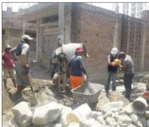
Figura 92. Asentamiento del concreto
