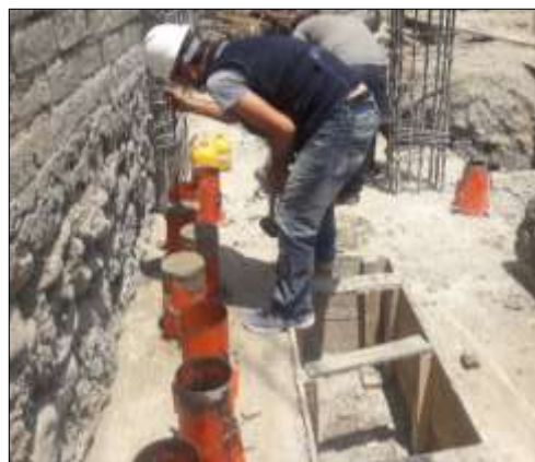
Figura 93. Elaboración de testigos de concreto
