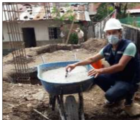
Figura 105. Elaboración de testigos de concreto
