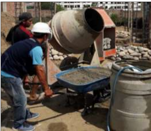
Figura 7. Muestreo de concreto en obra N° 03
