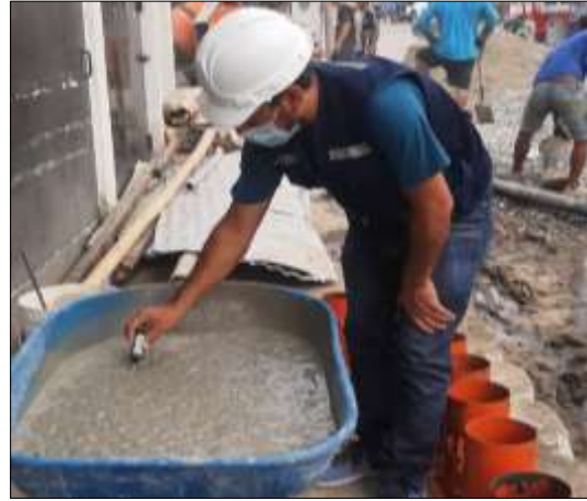
Figura 10. Realización de ensayo para medir la temperatura en obra N° 06
