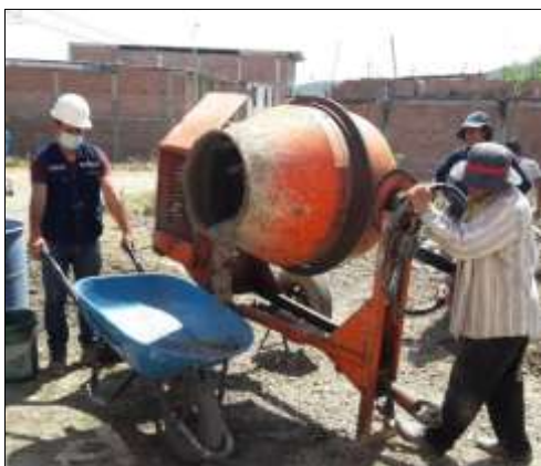
Figura 66. Muestreo de concreto
