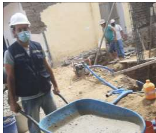
Figura 8. Muestreo de concreto en obra N° 04
