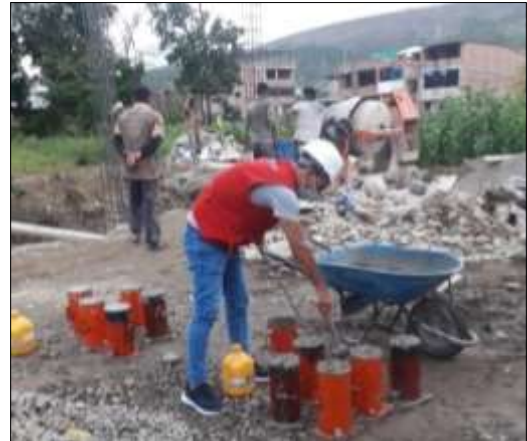
Figura 14. Elaboración de testigos de concreto en obra N° 10
