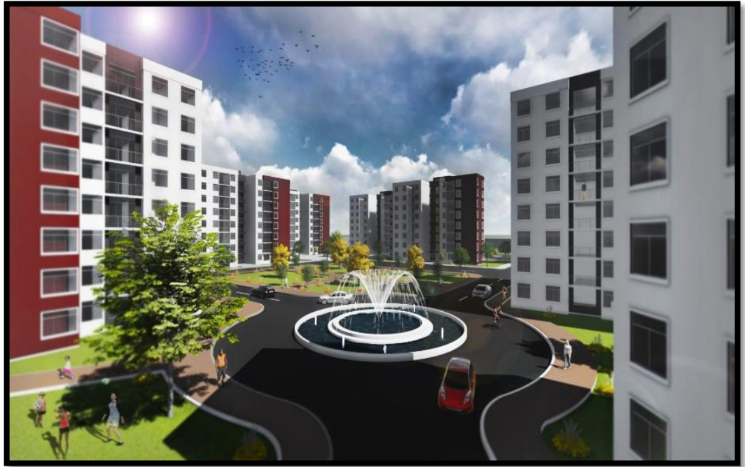
Figura 62. Vista Pileta Central
